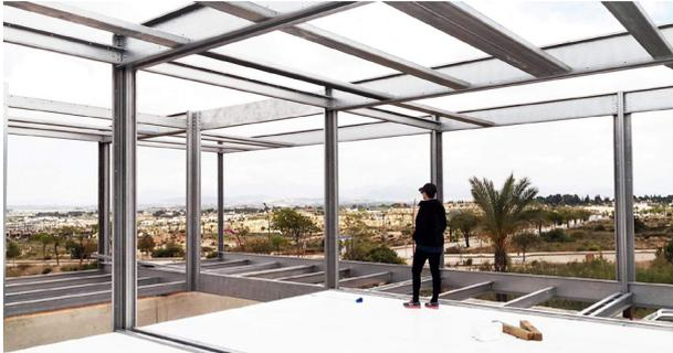
Estructura - acero conformado en frío
