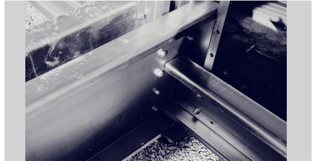
Estructura - acero conformado en frío
